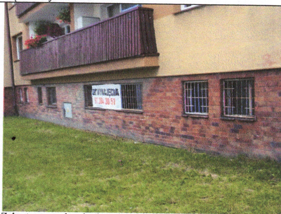
Zakratowane okna kotłowni CO.
