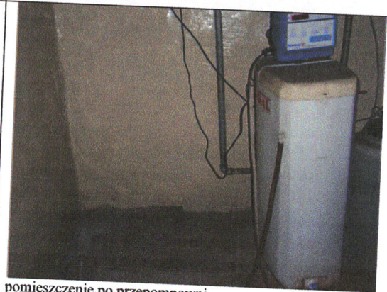
pomieszczenie po przepompowni
