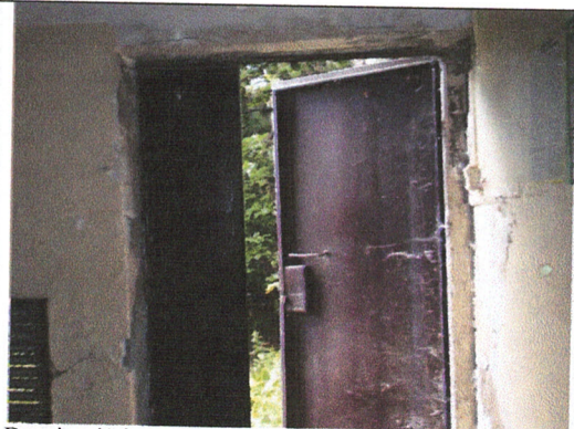
Drzwi wejściowe do pomieszczeń po kotłowni CO
