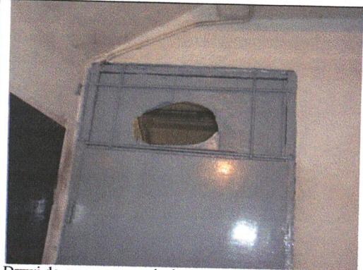
Drzwi do przepompowni z korytarza ogólnego podpiwniczenia
