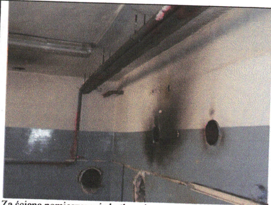
Za ścianą pomieszczenie kotłowni
