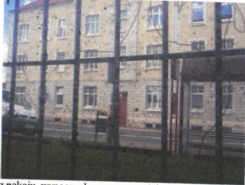
z pokoju wypoczynkowego w części socjalnej widok na budynek mieszkalny ul.Kościuszki 70
