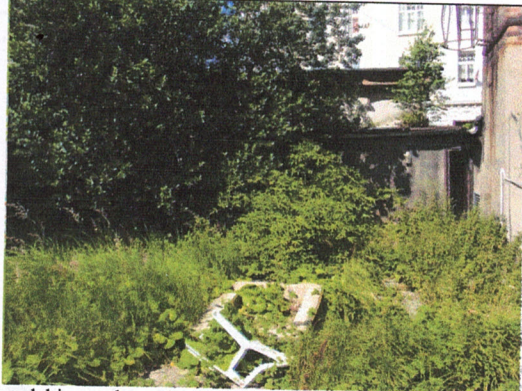
w głębi metalowe drzwi wejściowe do pomieszczeń po kotłowni CO. Wejście należy do dz. 33/11 Widać także kawałek komina.
